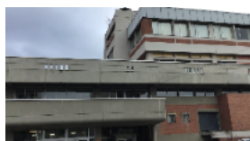
【写真① 常磐館】
